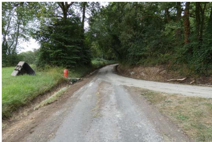
Chemin de Moquet, curage des fossés
